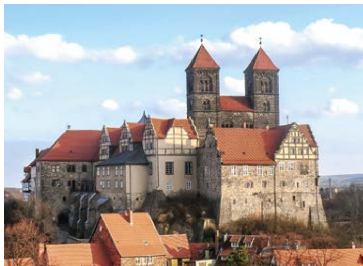
Stiftskirche St. Servatii Quedlinburg
