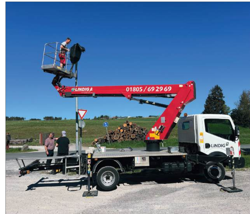
Installation der Sensoren im Oberharz
