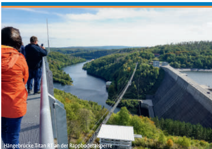
Hängebrücke Titan RT an der Rappbodetalsperre
